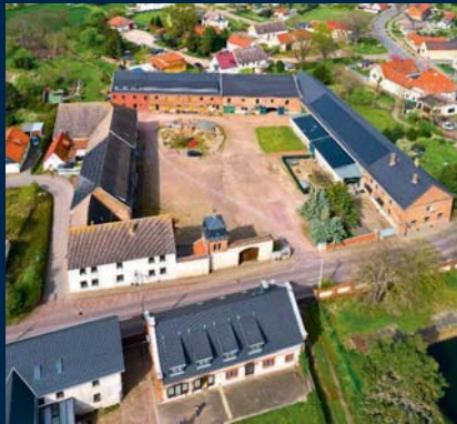
Historischer Gutshof „Hubbe“ 06193 Petersberg OT Kaltenmark Hallesche Straße 18 Pos. 19
