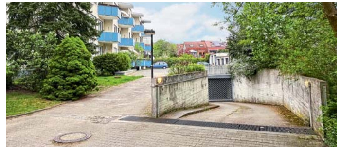
Tiefgarageneinfahrt im Innenhof
