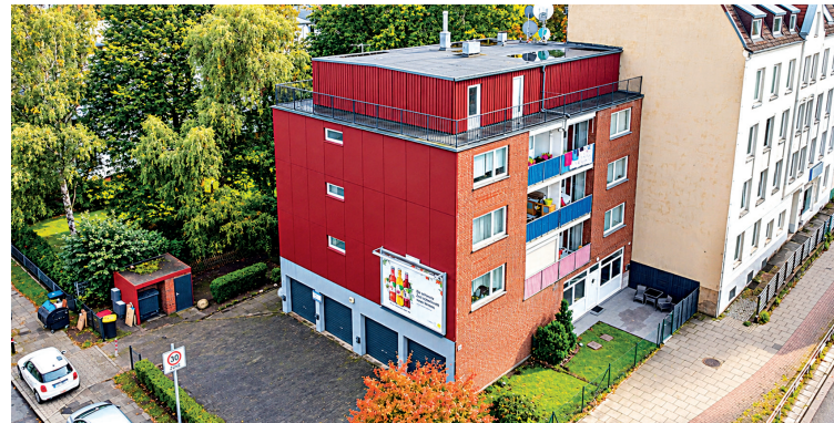
Mehrfamilienhaus 21107 Hamburg ST Wilhelmsburg, Georg-Wilhelm-Straße 214 Pos. 9
