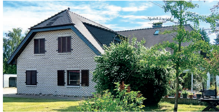
Zweifamilienhaus mit Nebengebäuden 17248 Rechlin Müritzsstraße 61 a Pos. 2
