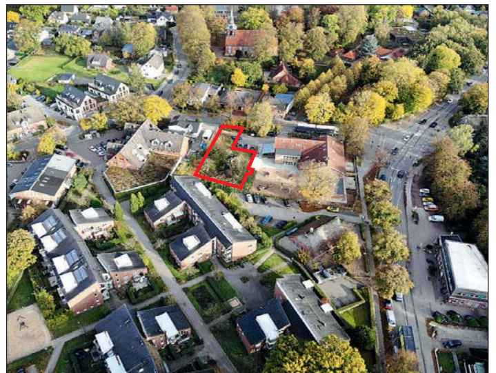
Baugrundstück in Hamburg OT Bergstedt , Pos. 07
